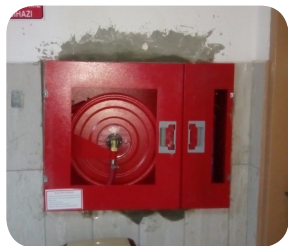
3 adet eski yangın dolabı değiştirildi.
