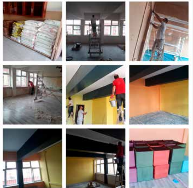
* İl Millî Eğitim Müdürlüğümüzün desteği ile Drama Atölyesi ve Zeka Oyunları Atölyesi&Okuma Salonu komple alçı çekildi, boyandı, parkesi yapıldı, pufları geldi. Çalışmalarımız devam etmekte...
