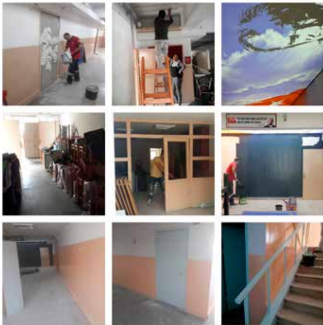
* Girişte güvenlik sorunu oluşturan rüzgarlıklar kaldırıldı. Geniş alan oluşturuldu. Anasınıfı girişine gergi tavan yaptırıldı. Bütün koridorların alçı tadilatı yapıldı ve boyandı. 32 kapımız da boyandı...
